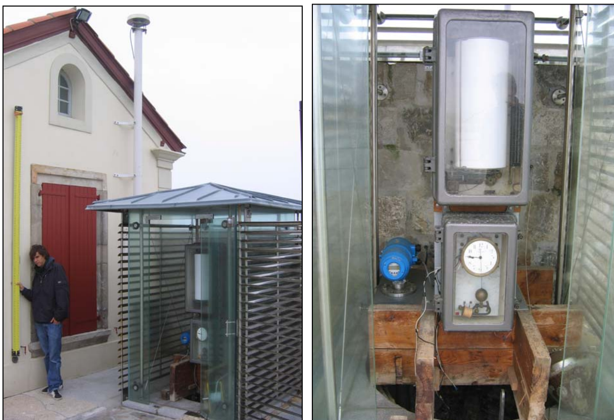
Fig.1 : Vue de gauche : marégraphe et antenne GPS permanente de Socoa (la mire est placée sur le repère J). Vue de droite : télémètre radar (en bleu à gauche) et marégraphe mécanique historique.
