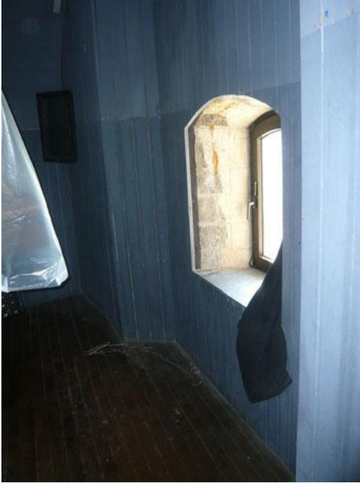
photo 7 : fenêtre de la casemate où était installé le marégraphe
