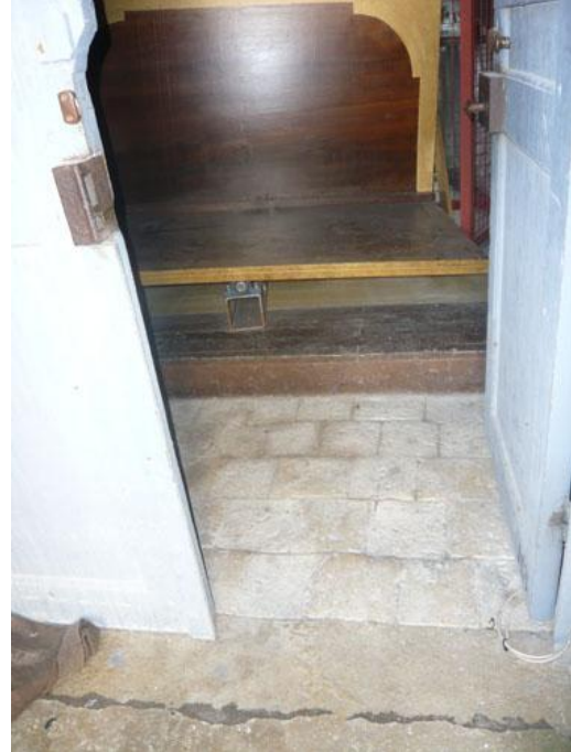
photo 8 : sol de la casemate où était installé le marégraphe (partie en pierres d'origine, parquet ajouté ensuite)
